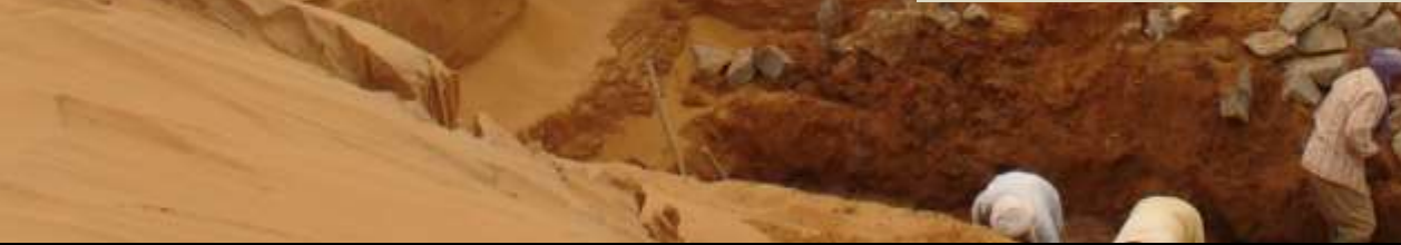
Costruzione di un sistema di captazione dell'acqua sotto le dune 'Khattara'
